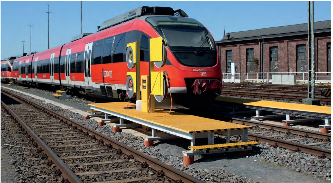
Abb 3: GFK-Einstiegspodest mit Aufroller für Druckluft und Stromversorgung
