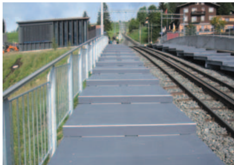
Hausperron mit Stahlgeländer (Sektor B).
