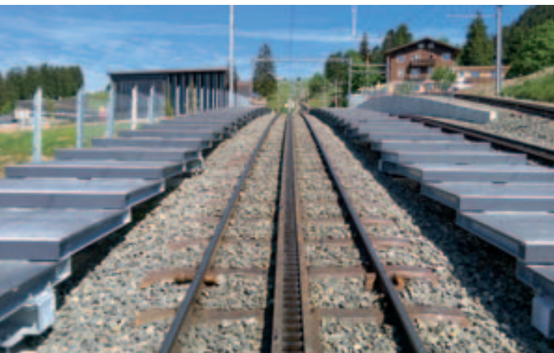
Gleis 1 zwischen Haus- und Mittelperron (Sektor B).
