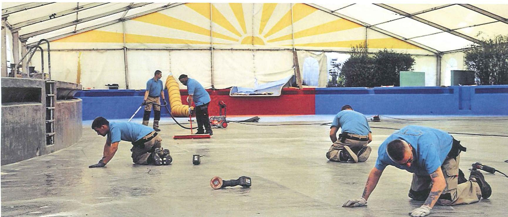
**Drei Schichten Glasfasermatten**, die zuvor in Vinylharz getränkt wurden, schützen künftig den Beckenbeton. Nachdem die Fläche geschliffen worden ist, wird noch eine blaue Farbe auf Polyesterbasis aufgetragen. Für mindestens 15 bis 20 Jahre soll die Anlage nach der Sanierung geschützt sein.
