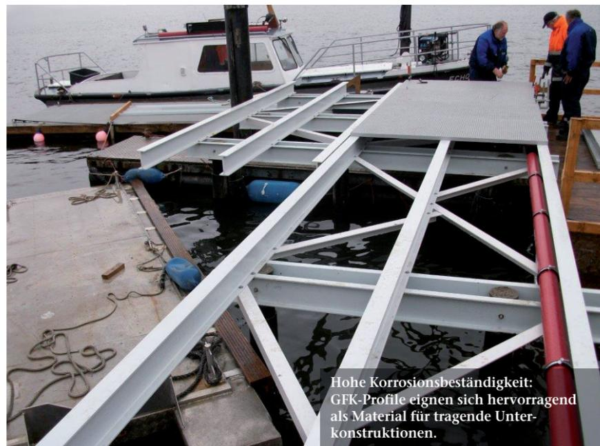
Hohe Korrosionsbeständigkeit: GFK-Profile eignen sich hervorragend als Material für tragende Unterkonstruktionen.
