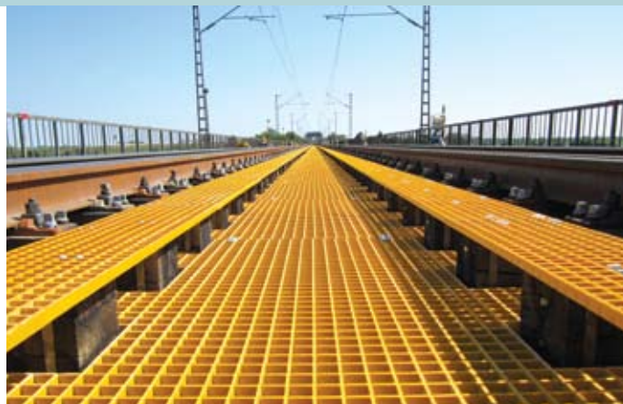
Gewichtseinsparung an einer Eisenbahnbrücke | Bilder: CTS Composites
