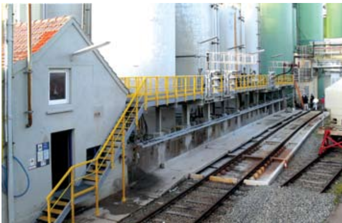
Neue Laufstege an einer Säureumschlagsanlage
