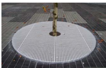
Baumring: hergestellt aus Gitterrosten
