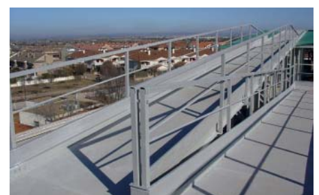
Rampe mit Unterkonstruktion: hergestellt in CTS Systemtechnik
