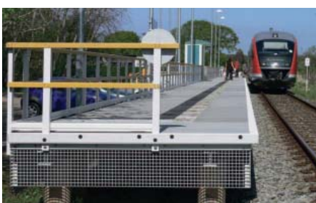
Bahnsteig mit Unterkonstruktion: hergestellt in CTS Systemtechnik, erster GFK-Bahnsteig weltweit (ARGE HTG Ingenieure Schwerin/CTS)
